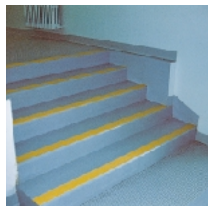
Pavimentación realizada en la Escuela Elemental "Fraggianni" (Bari)
