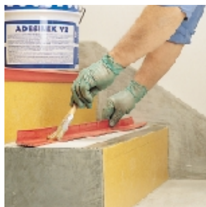
Aplicación de ADESILEX VZ sobre rodapié de PVC
