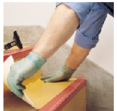
Aplicación de ADESILEX VZ sobre el dorso del revestimiento de PVC
