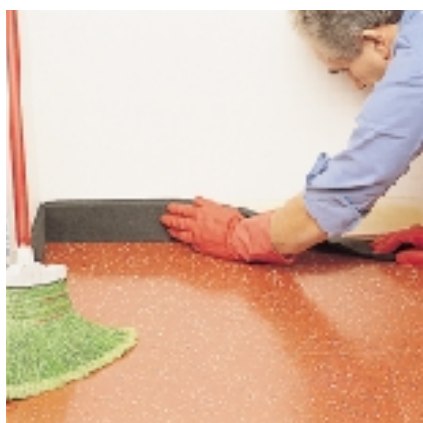
Colocación del zócalo de PVC
