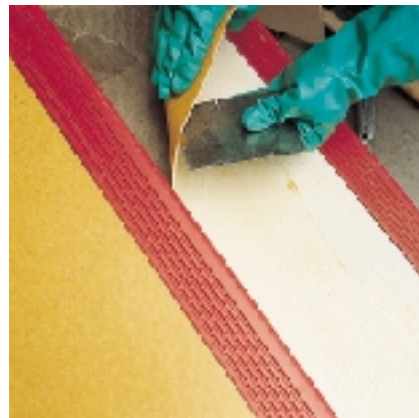
Colocación de PVC sobre escalones
