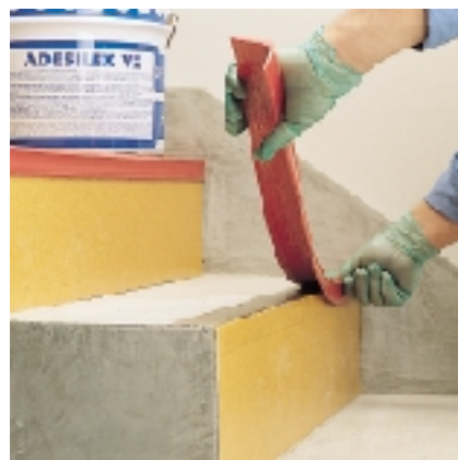
Colocación del rodapié de PVC
