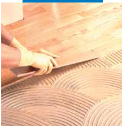
Colocación del parquet
