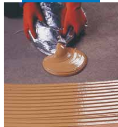
Ecurrido del adhesivo en el ángulo inferior
