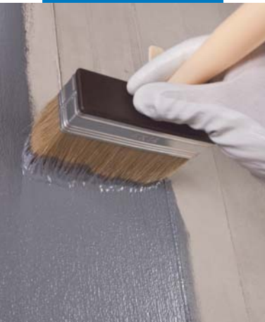
Aplicación de Eco Prim Grip con brocha sobre un soporte de hormigón
