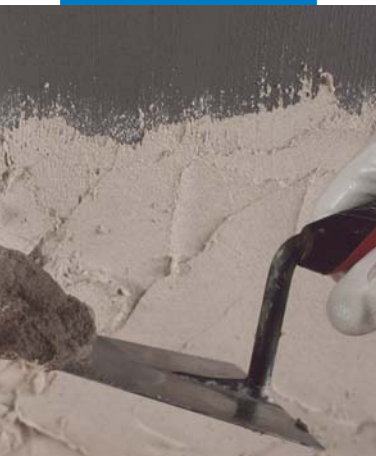
Aplicación de un revoque sobre Eco Prim Grip
