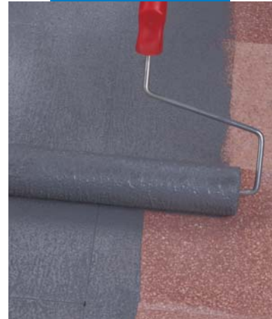
Aplicación de Eco Prim Grip sobre rodillo sobre viejo pavimento de baldosas hidráulicas
