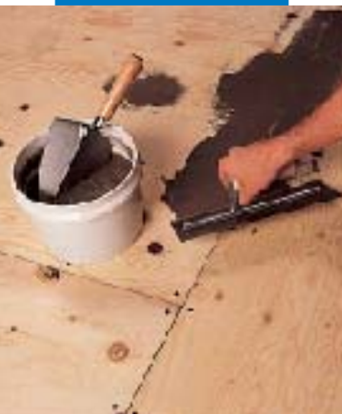
Rellenado de juntas e soportes de madera compensada con Nivorapid + Latex Plus
