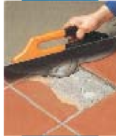
Relleno de agujeros con Nivorapid
