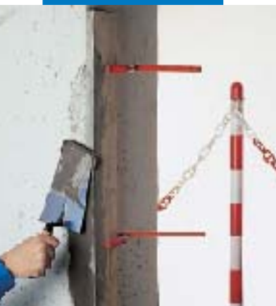
Reparación de ángulo vertical con Nivorapid
