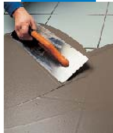
Nivelado de pavimento preexistente con Nivorapid
