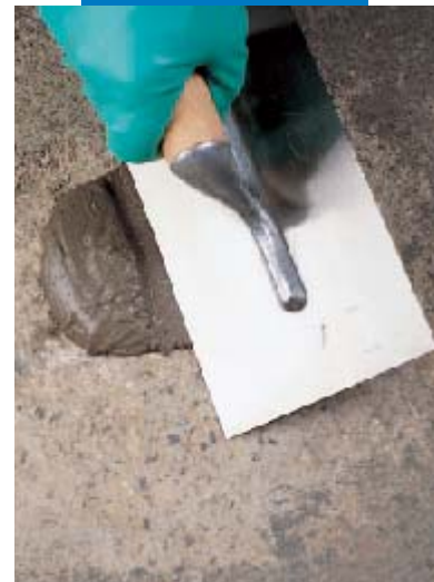
Reparación de ángulo horizontal con Nivorapid
