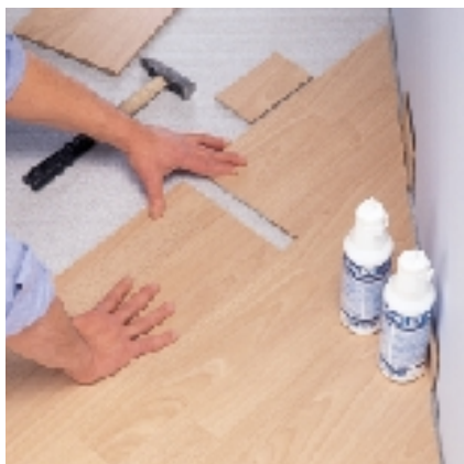
Posicionamiento en lámina del machihembrado (parte masculina y femenina)
