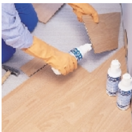
Extensión en lámina del ADESIVIL D3 en la parte femenina del machihembrado
