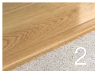
Junta de transición De madera a moqueta.
